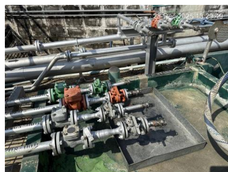
ภาพที่ 11 ถาดรองน้ำมันที่อาจหกรั่วไหลจากการถอดท่อและข้อต่อในการขนถ่ายน้ำมันที่ท่าเรือ
