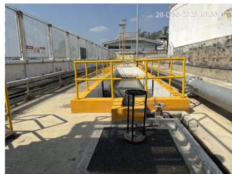
ภาพที่ 9 ปอดักครบน้ำมัน Oil interceptor เพื่อทำการแยกน้ำมันออกจากน้ำก่อนระบายสู่สาธารณะ
